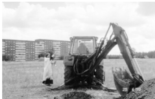
Протоиерей Олег Богданов благословляет «первый ковш» при рытье котлована под фундамент Рождественского храма
